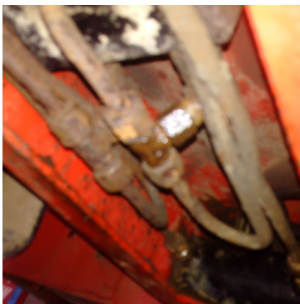
Kuva 2.7: Ruostuneet putket. Taustalla musta sylinteri.
